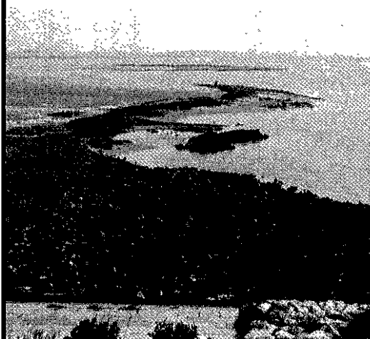
Het middelste gedeelte van de grindloper is door de stroom opgeruimd
